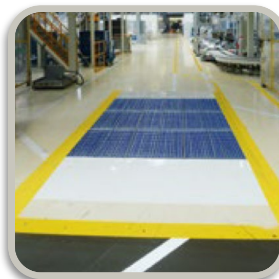
エポキシ樹脂製の ランプと地上の設置
